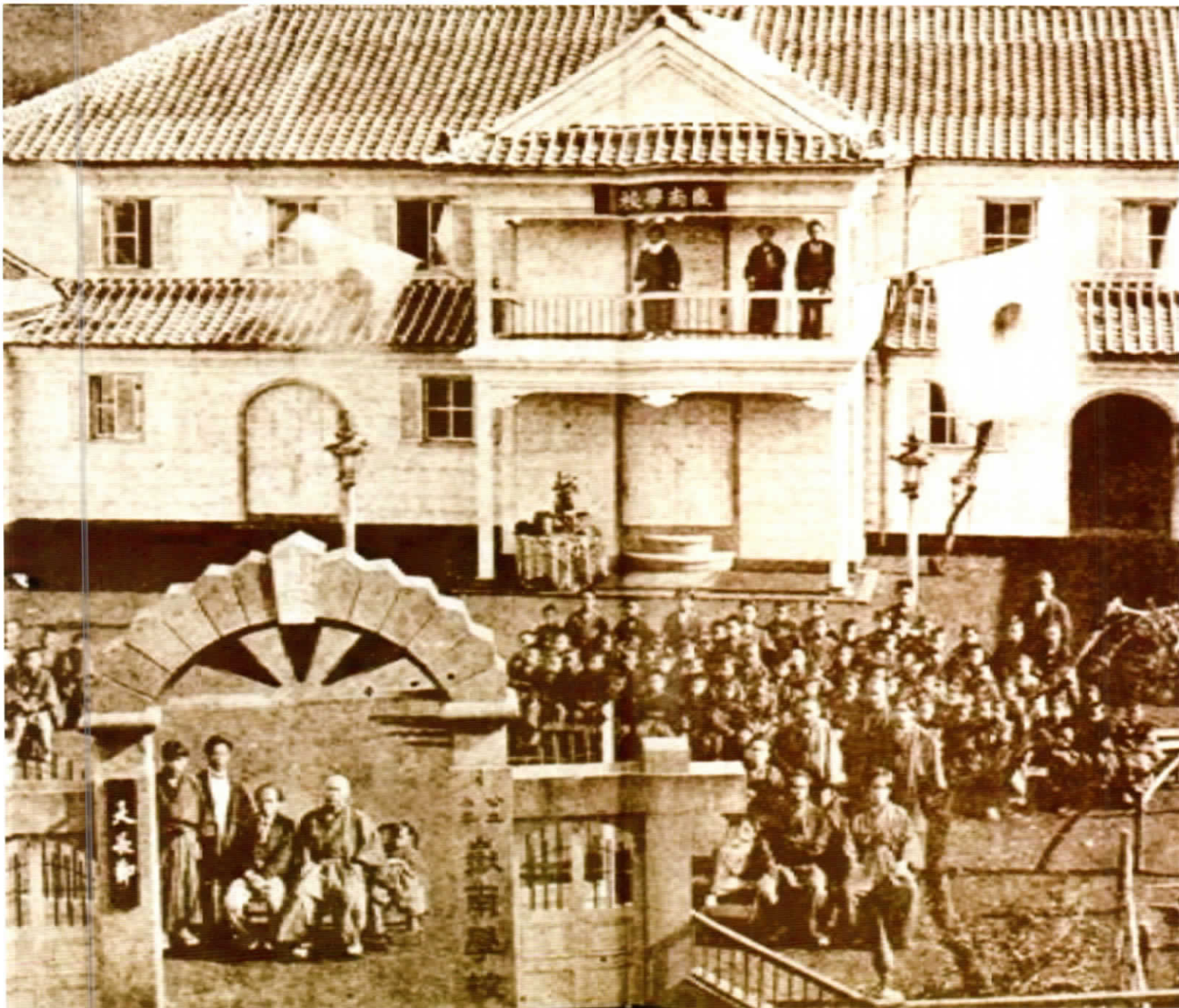
明治15年 御宿平山に建てられた嶽南学校
